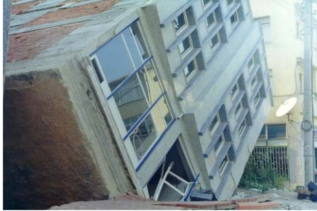
Şekil 1. 1999 Kocaeli depremi sırasında meydana gelen sıvılaşma örneği
